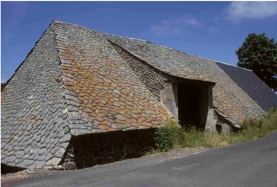
Alberoché (Cantal), 1996. Admirable volume de toiture d'une grange étable dont les maçonneries se perdent, au-dessous, dans la pente. La croupe gauche descend plus bas que le long pan.
