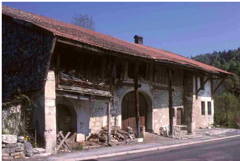
Boujeons (Doubs), 1998, retrait partiel de la façade à l'abri du pignon gauche.
