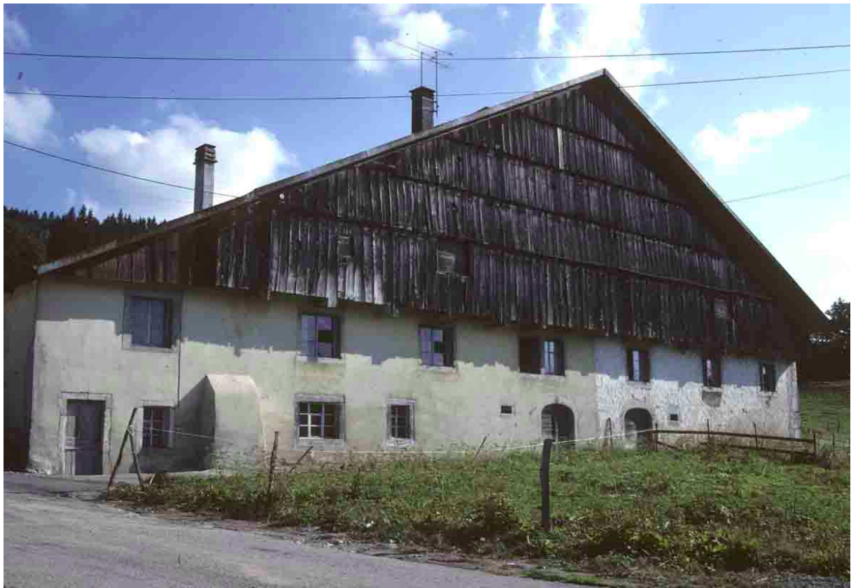
Grand-Fontaine-Fournets (Doubs), 1989, maison du haut Doubs à pignon frontal, à double logis et double corps d'exploitation. Les deux granges hautes sont accessibles, à l'arrière, par deux ponts de grange. Les pignons habités sont donc toujours du côté le plus bas de la pente.
