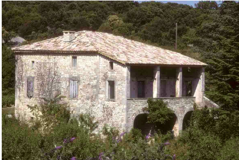
Le Garn (Gard), 2001, avant corps constitué d'une galerie et de caves, plaqué sur le volume simple de la maison.
