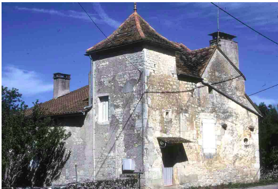
Beaumat (Lot), 1997. Un pigeonnier massif s'élève à l'angle de cette maison dont le volume se complexifie grâce à un retour de toiture en équerre, une demi-croupe et deux cheminées.
