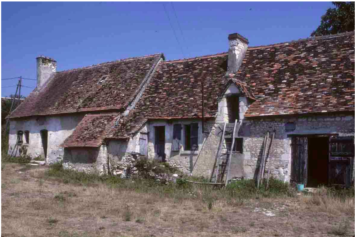
Azay-le-Ferron Champdeuf (Indre), 1990. Deux maisons typiques de la Brenne. Deux vraies maisons paysannes, sous leur toit de tuile plate, héritées presque sans altérations des XVIIIe et XIXe siècles.
