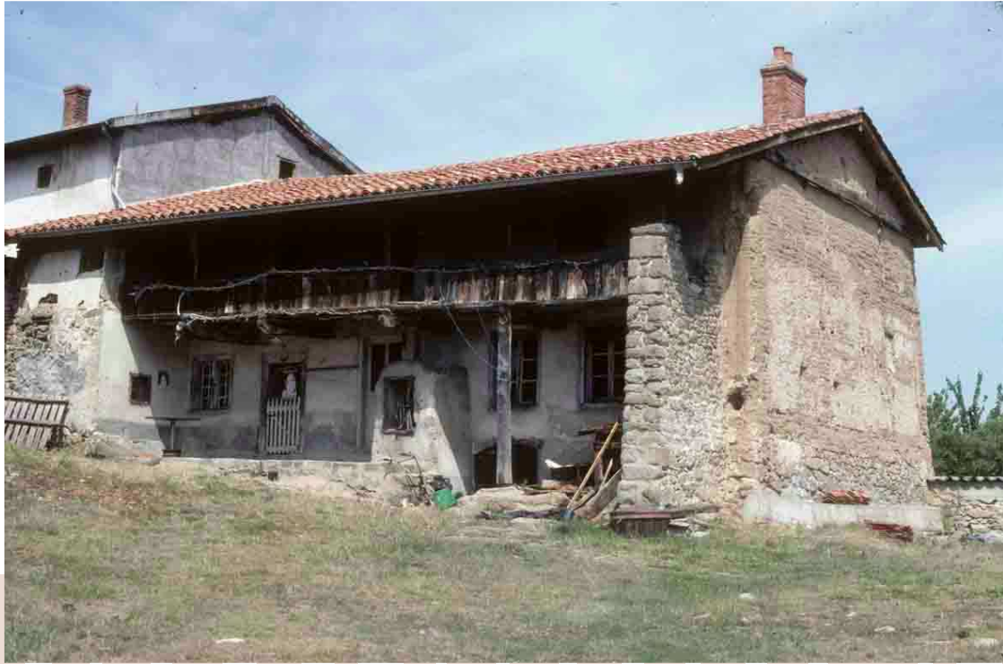
Ailleux (Loire), 2003, maison en pisé, avec ses aîtres, ou galerie. Ce logis, en retrait de façade, est bien protégé par le pignon et l'avancée du toit.
