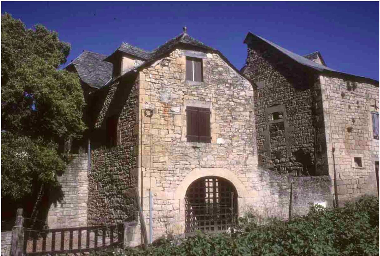
Grand-Mas (Aveyron), 1999, maison à volume complexe sur le causse Comtal. L'arbre, à gauche, accompagne l'élévation des bâtiments.
