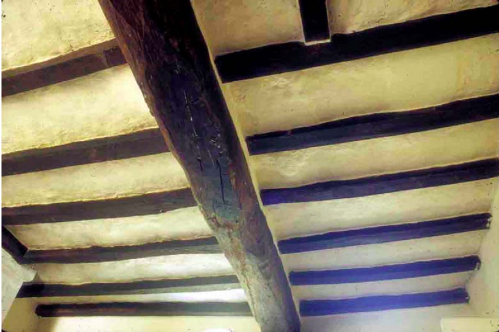
les Caves (Maine-et-Loire), 2003, une poutraison constituée d'un sommier et de solives, entre lesquelles est appliqué un enduit.
