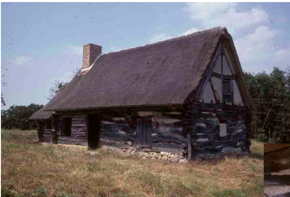
Thionne, Goyette (Allier), 1986. Maison en poutre sur poutre de Sologne bourbonnaise.
