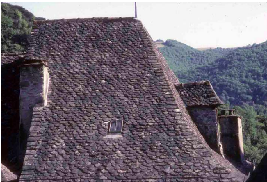
Conques (Aveyron), 1998, toit de lauze de schiste très pentu, rendu utilisable par la mise en place d'une lucarne.
