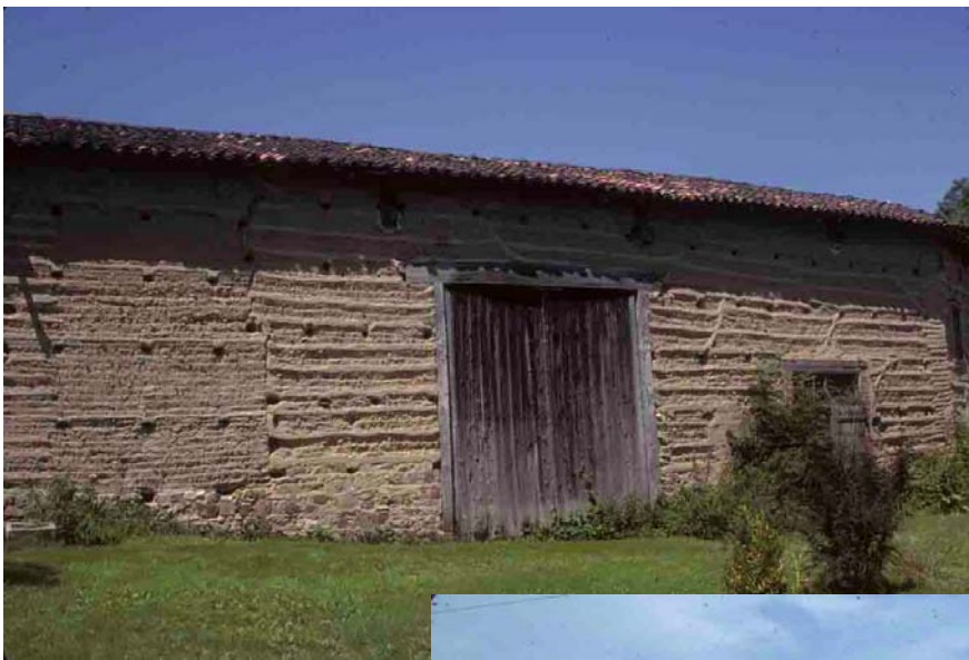
Sermantizon, le Burnoux (Puy-de-Dôme), 2001, grange-étable construite en pisé.
