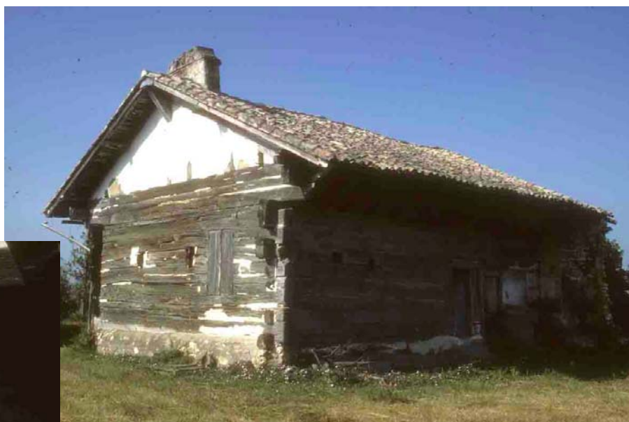
Naresse (Lot-et-Garonne), maison à empilage de poutres. Le triangle du pignon est en pan de bois. A gauche, détail de l'assemblage d'angle entre un pignon et une façade.
