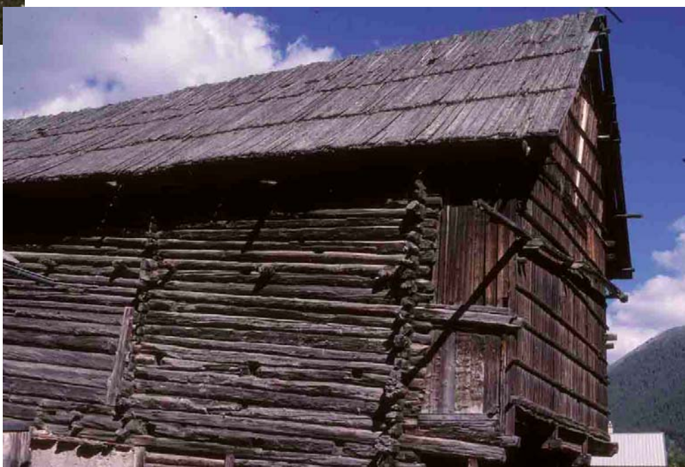
Molinès-en-Queyras (Hautes-Alpes). Dans la vallée de Saint-Véran, une fuste constituée de poutres très jointives, sous un toit de grands bardeaux de mélèzes.
