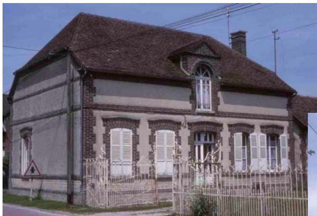
Les Grandes-Chapelle (Aube), 1998, encadrements d'ouvertures, corniches, chaînages et bandeaux : la brique souligne de façon décorative une maçonnerie de pierres enduite.
