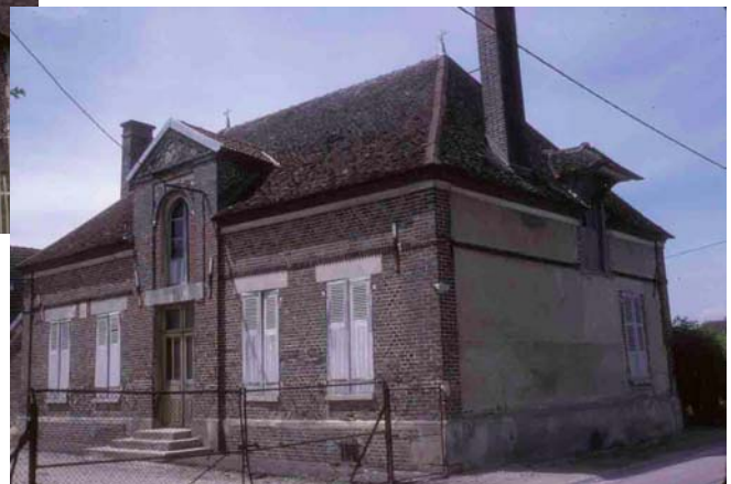
Les Grandes-Chapelle (Aube), 1998, encadrements d'ouvertures, corniches, chaînages et bandeaux : la brique souligne de façon décorative une maçonnerie de pierres enduite.
