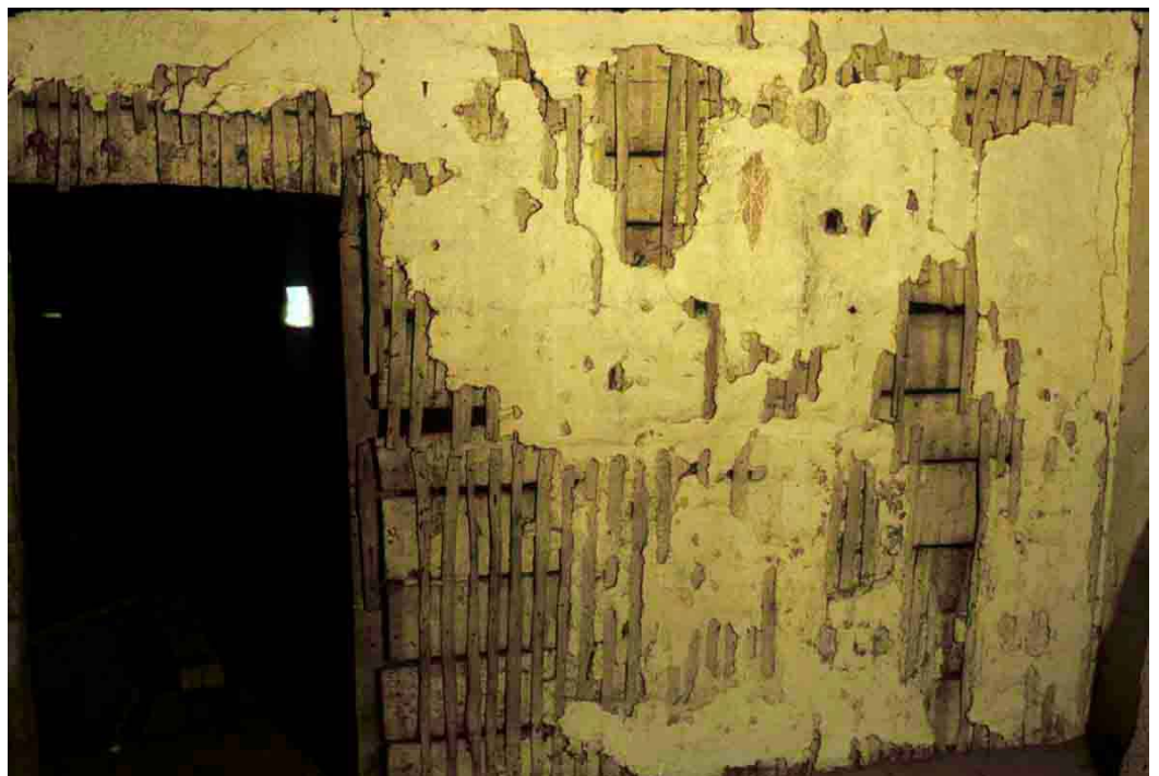
Génicourt-sur- Meuse (Meuse), 1982, une cloison constituée, de façon classique, de madriers plâtrés sur lattis.
