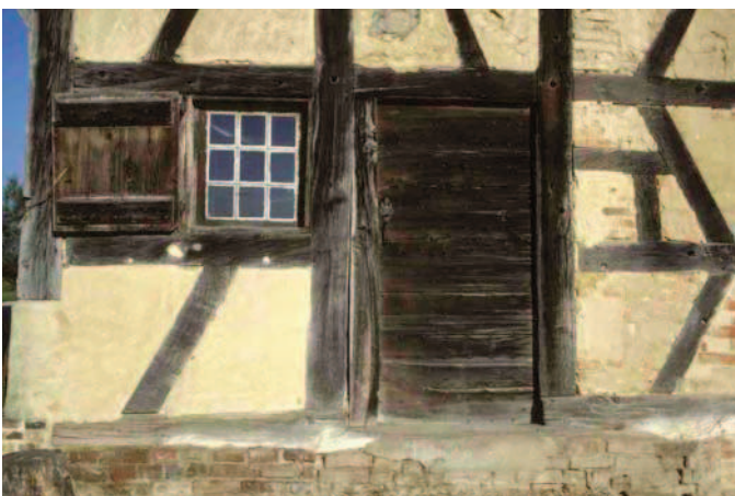
Mais ces deux matériaux, issus de la même terre glaise, demandent l'usage de la brique ou de la pierre pour assurer leur soubassement étanche. A gauche, Courtes, la Forêt (Ain), 1989 ; à droite, Courtes, la Grange-Baron (Ain), 1994.
