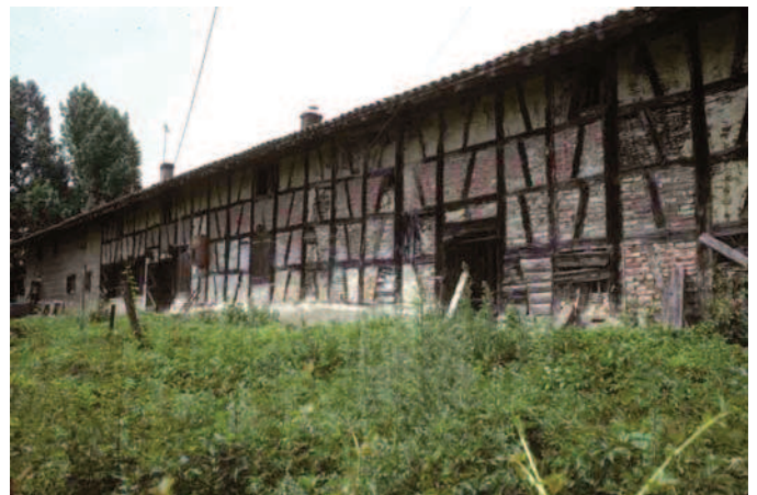
Mantenay-Montlin, le Brouillard (Ain), en se transformant en pisé (2002), la terre crue a échappé au cadre rigoureux du pan de bois où elle prenait forme de torchis (2001).
