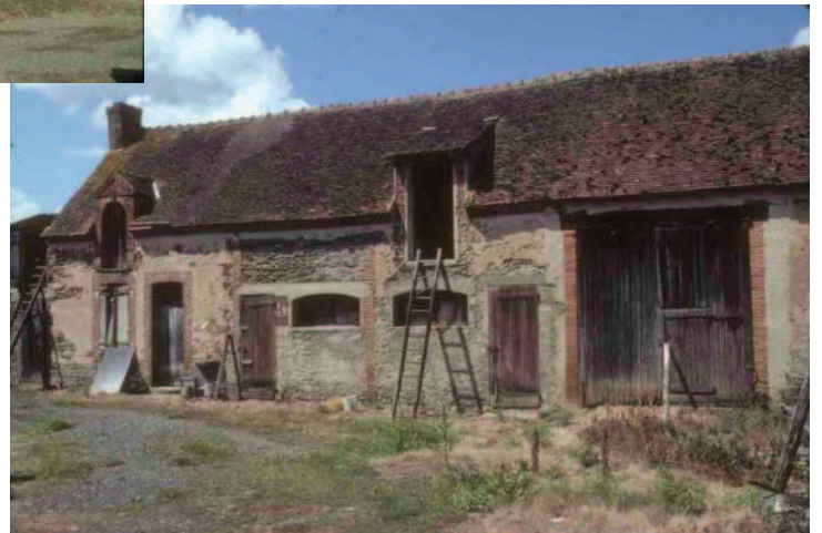
Les Chérons (Indre, 2009, maison berrichonne en schiste, avec encadrements de brique.
