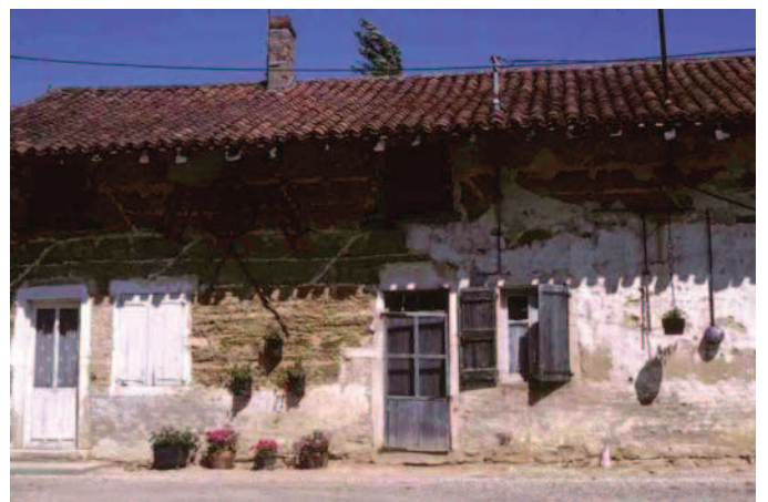
Mais ces deux matériaux, issus de la même terre glaise, demandent l'usage de la brique ou de la pierre pour assurer leur soubassement étanche. A gauche, Courtes, la Forêt (Ain), 1989 ; à droite, Courtes, la Grange-Baron (Ain), 1994.
