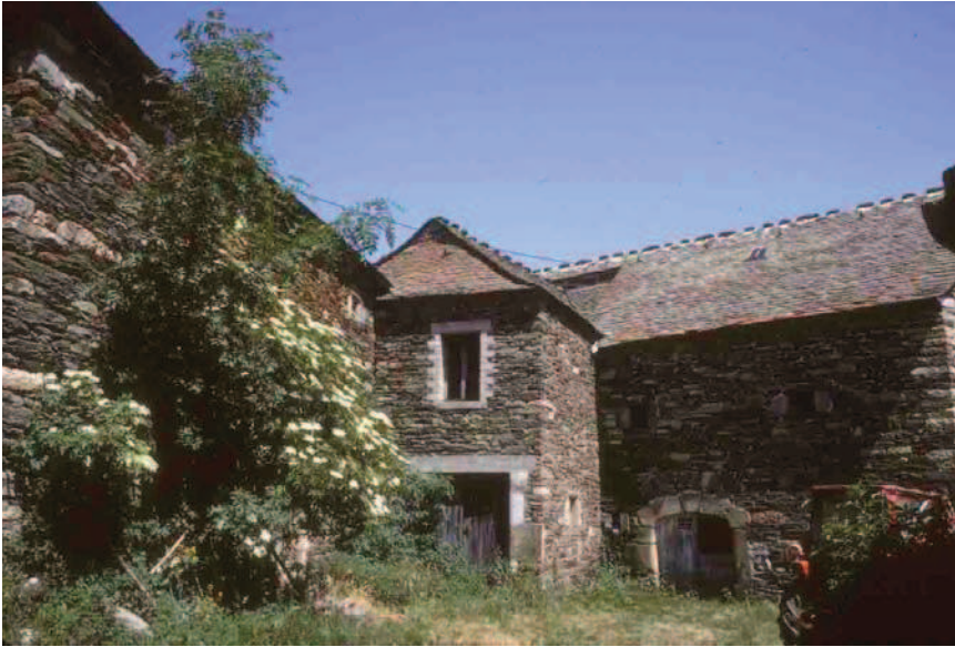
Le Oultet (Lozère), 1994, schiste en toiture et en maçonnerie, bois en charpente, en sols d'étage et en menuiseries d'ouvertures.
