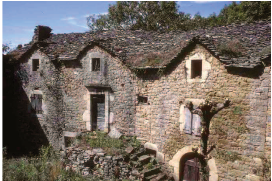
Blayac (Aveyron), 1994, calcaire en toiture, en maçonnerie, en voûtes et en sols, bois pour les menuiseries d'ouvertures.
