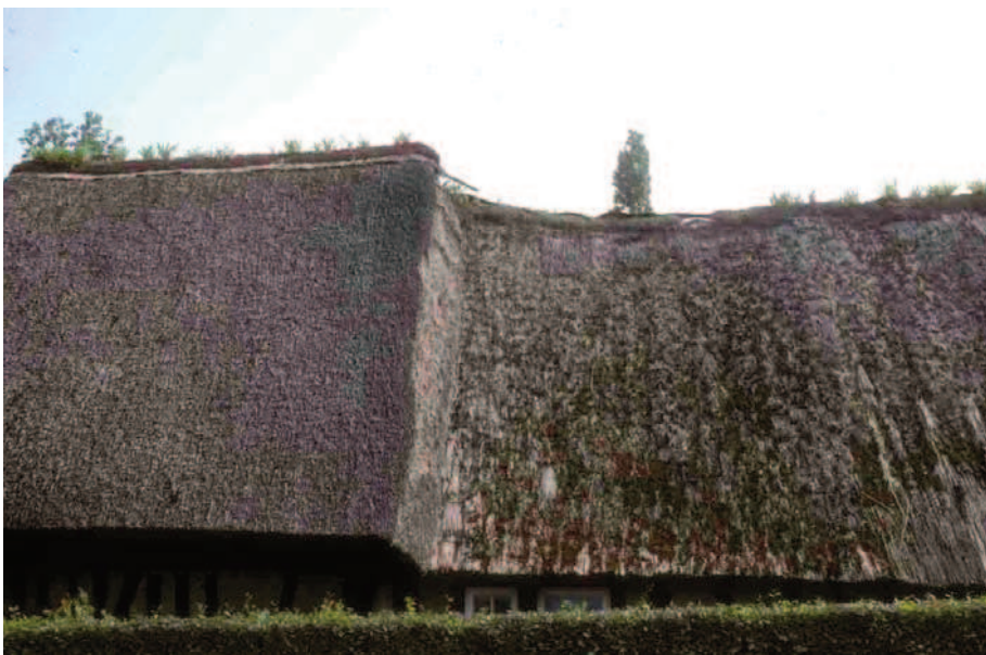
Combon (Eure), 1994, roseau ) gauche, seigle à droite, la différence d'apparence entre ces deux matériaux saute aux yeux.
