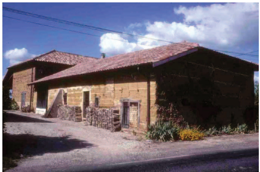
Bagé, la Ville-Laval (Ain), 2008, terre cuite en toiture et en sols de rez-de-chaussée, terre crue en maçonneries, bois en sols d'étages et en menuiseries d'ouvertures.
