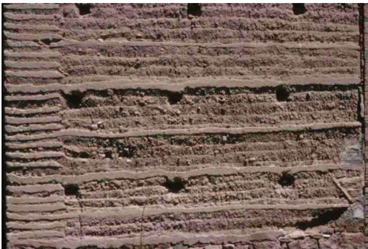
Sermantizon (Puy-de-Dôme), 2001, pisé, avec joints horizontaux et chaînage d'angle à la chaux.
