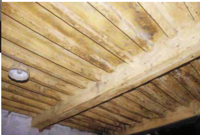
Narbéfontaine (Moselle), 2001, plafond à la française avec sommiers et solives, recouverts d’une dalle de plâtre dite oestrich ou estrich.
