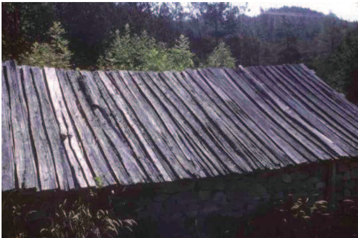
La Clusaz (Savoie), 2001, toiture restaurée en petits bardeaux d'épicéa.
