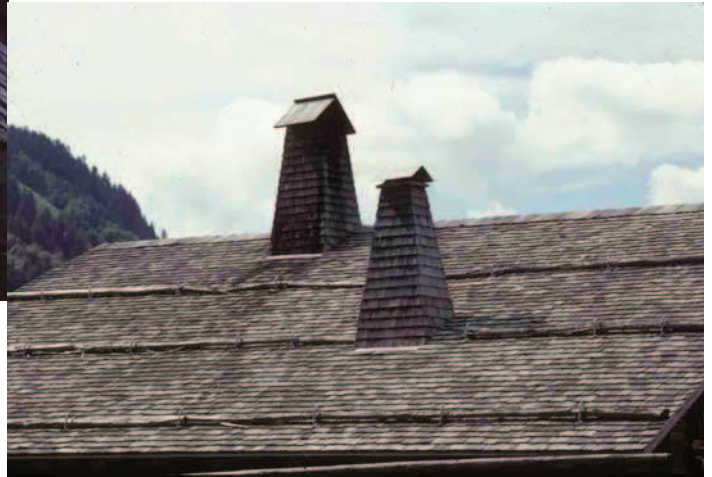
La Clusaz (Savoie), 2001, toiture restaurée en petits bardeaux d'épicéa.
