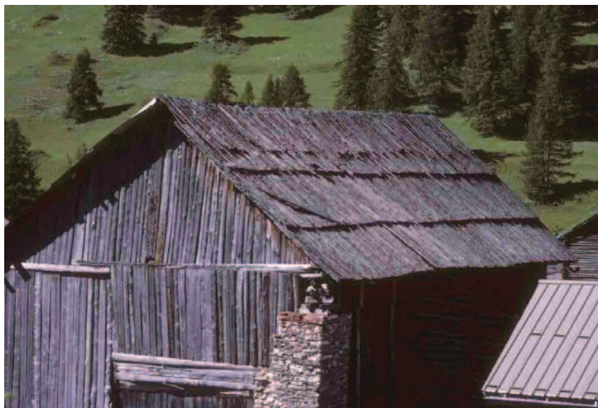
Molinès-en-Queyras (Hautes-Alpes), 2000, bois en toiture, en charpente et en clos vertical, pierre au rez-de-chaussée.
