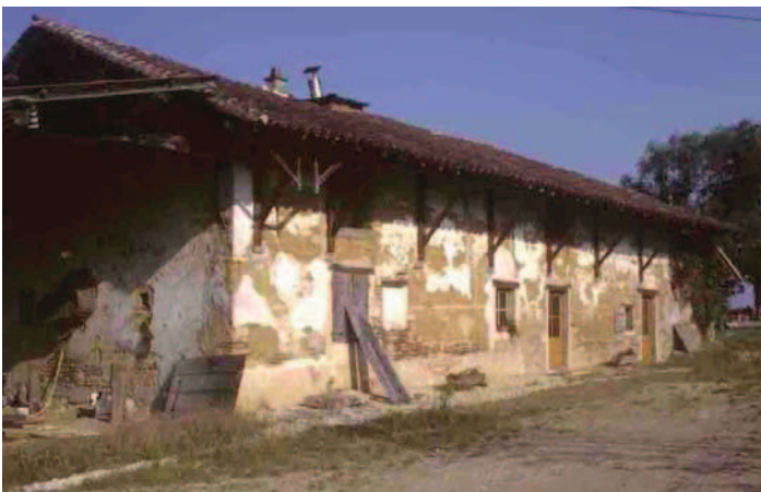
Mantenay-Montlin, le Brouillard (Ain), en se transformant en pisé (2002), la terre crue a échappé au cadre rigoureux du pan de bois où elle prenait forme de torchis (2001).
