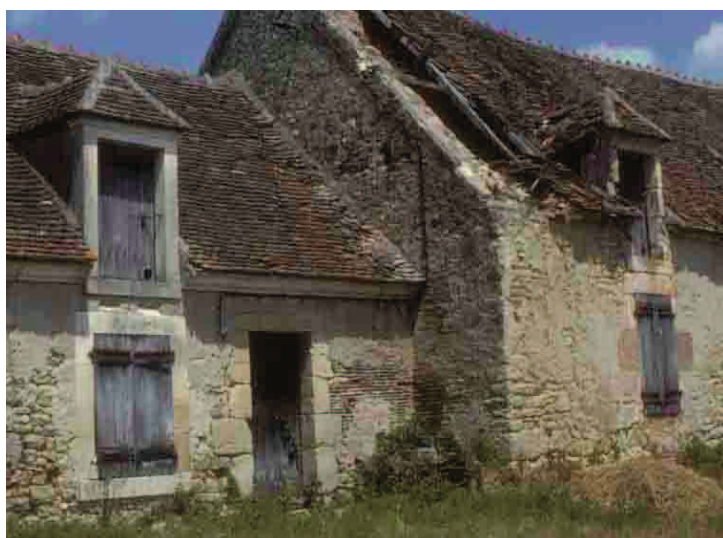
Martizay le Jonc (Indre), 1990, porte et fenêtre de logis réunies dans le même encadrement de pierre calcaire, mais la fenêtre ne porte qu'un linteau monolithique tandis que celui de la porte possède une clef.
