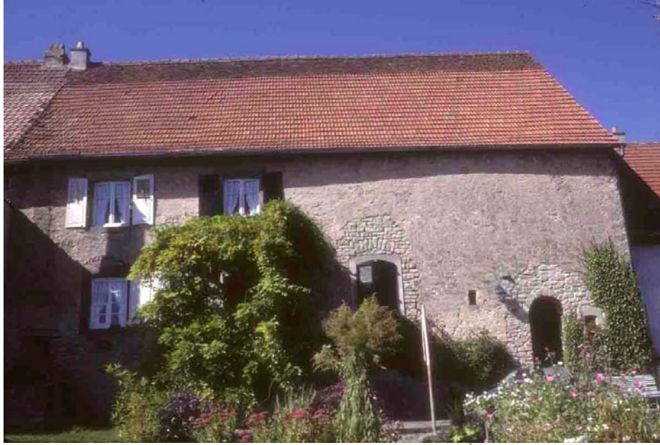
Façade arrière d'une maison de Niederstinzel (Moselle), 1997. l'essentiel des ouvertures se portent sur le logis, à gauche, ce qui met en valeur une grande surface de maçonnerie, au niveau du corps d'exploitation.
