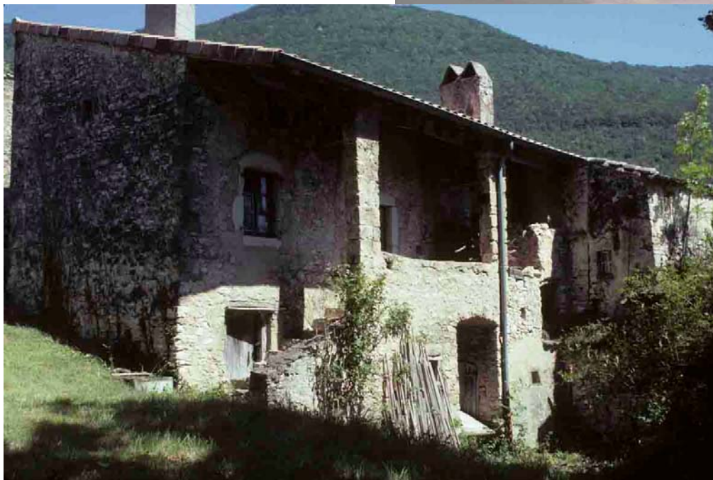
Ansage (Drôme), 2010, devant la façade s'est mise en place une véritable pièce à vivre au dehors, sous forme d'un escalier extérieur et d'un auvent de toiture porté par deux piliers de pierre. On peut, dès lors, parler d'une façade habitable. Le logis, bien sûr, est reporté à l'étage.
