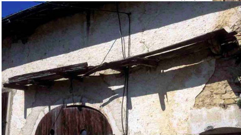
Faverge (Jura), 2012, l'avant-couvert de la maison jurassienne prend la forme d'un petit balcon porté par de courtes poutres. Il était destiné à conserver le bois de chauffage.
