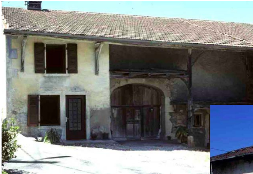
Faverge (Jura), 2012, l'avant-couvert de la maison jurassienne prend la forme d'un petit balcon porté par de courtes poutres. Il était destiné à conserver le bois de chauffage.
