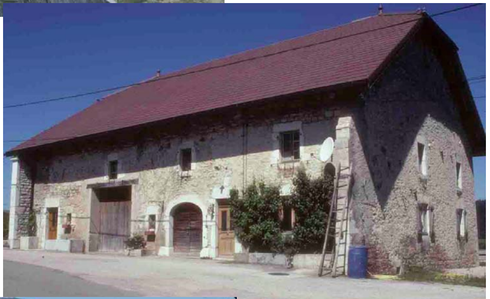
Les Bouviers (Jura), 2010, la façade est encadrée par les deux pignons qui la protègent, en permettant au toit de former auvent. Ainsi, la façade se met en retrait du soleil et de la pluie. Le pied de la façade devient de la sorte un lieu de travail relatif, en même temps qu'un lieu de détente, comme le montrent les arbustes, à droite.
