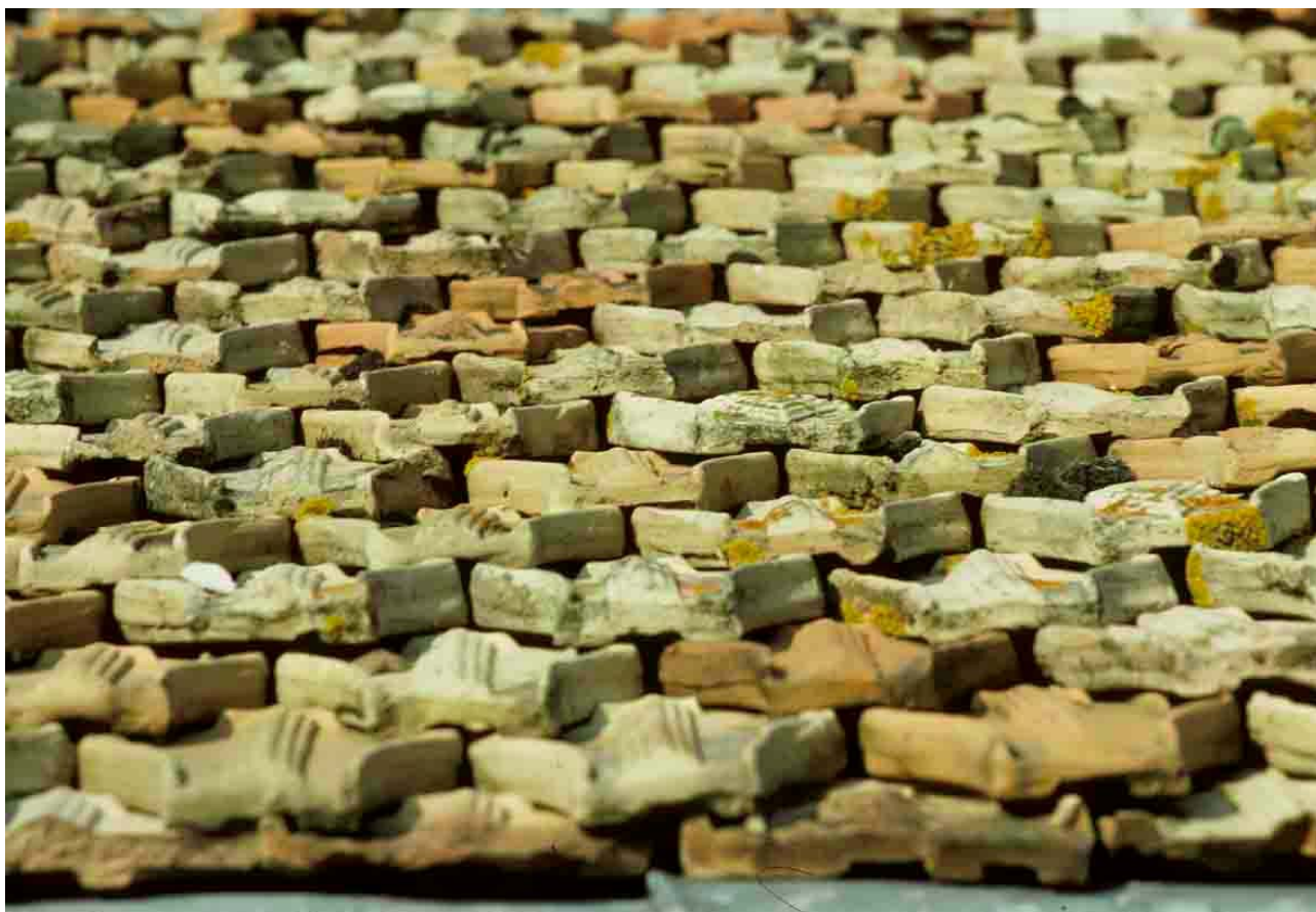
Taillancourt (Meuse), 1977, gros plan du toit du lavoir.
