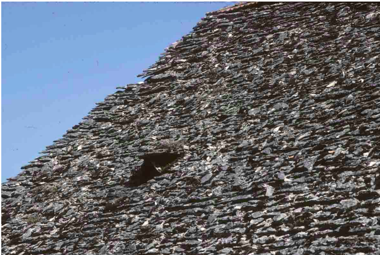
Mouilleron (Haute-Marne), 1994, houteau destiné à aérer la sous-couverture.
