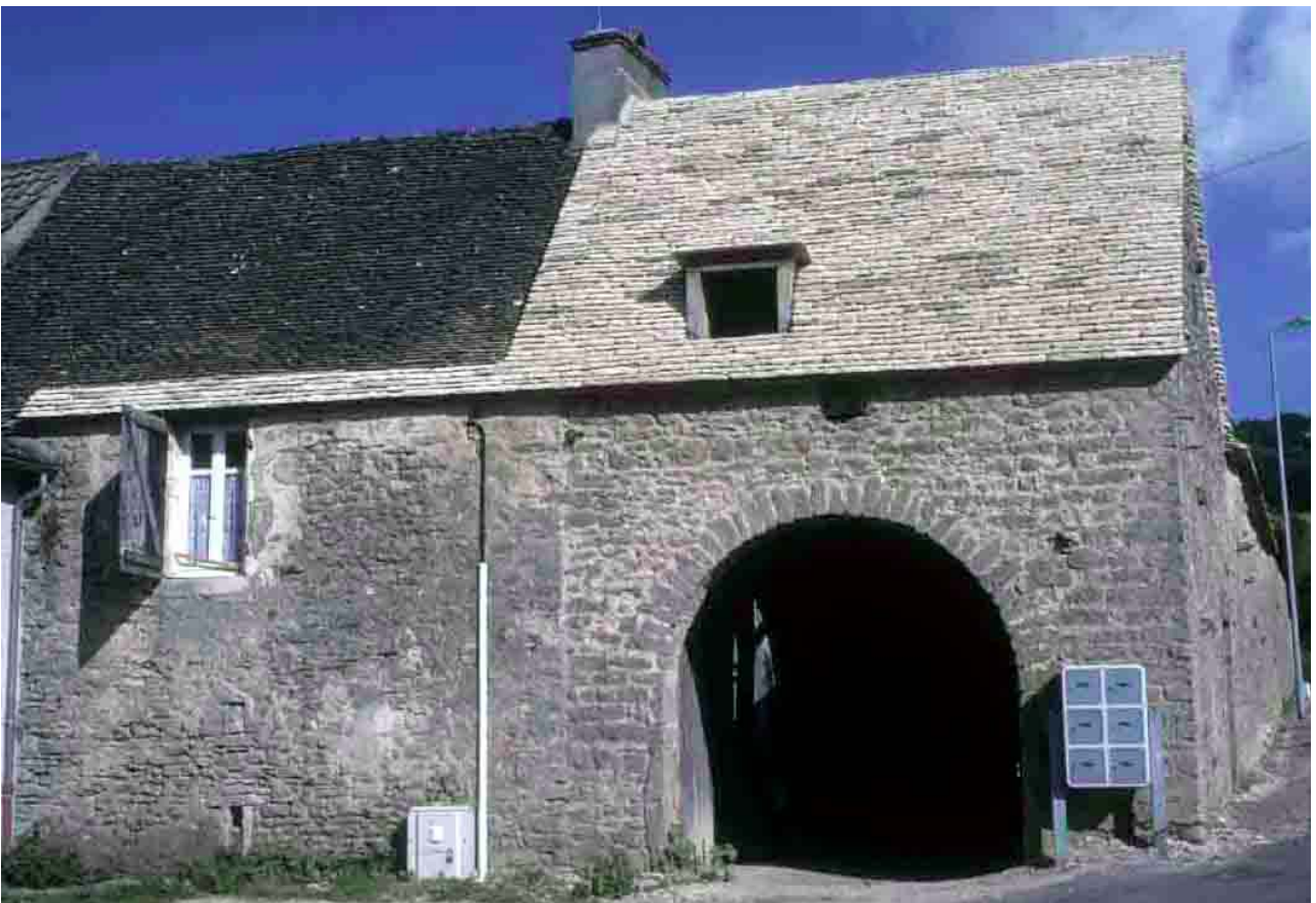
Saint-Denis-de-Vaux (Saône-et-Loire), différence de ton, à droite, entre la lave récemment extraite de la carrière et, à gauche, la lave oxydée par l'air.
