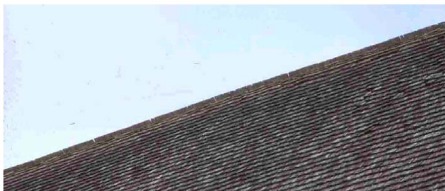
Montenay (Mayenne), 1994, faîtage en lignolet.
