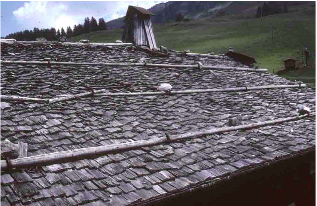
Chenaillon (Haute-Savoie), 1987, ces longues perches permettaient de maintenir la neige sur les toits, dont elle assurait l'isolation.
