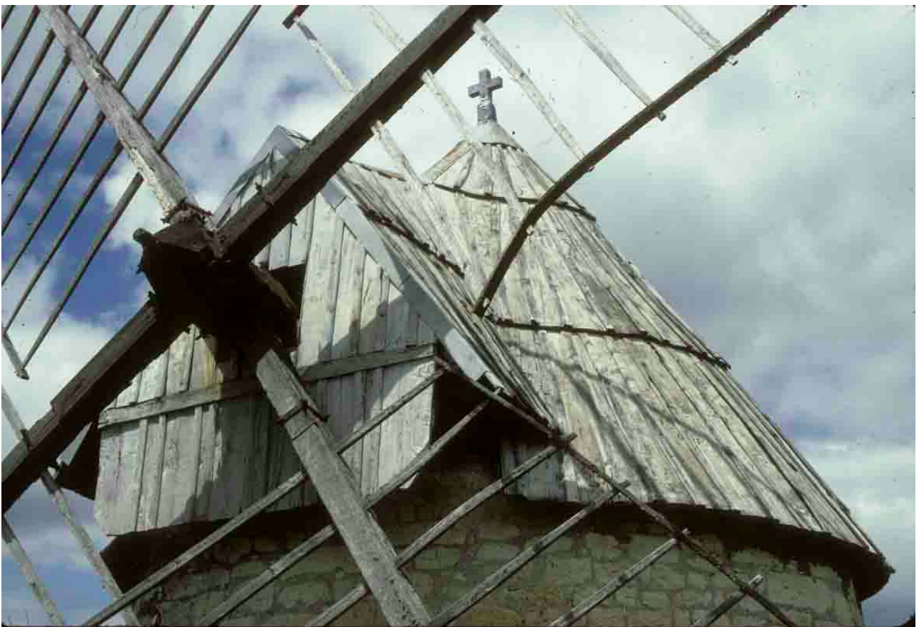
Castelnaud-Montratier (Lot), 1993, toit de bois pivotant de moulin.
