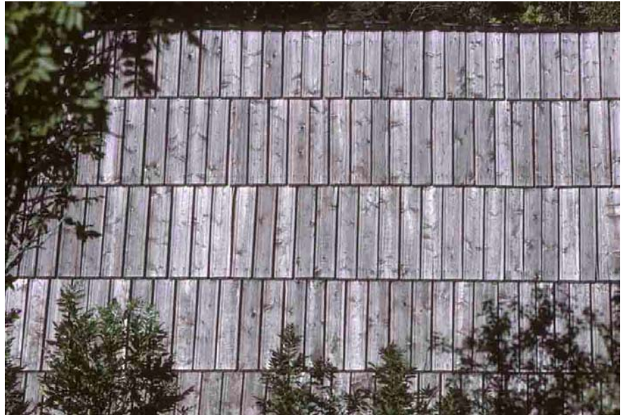
Méloans (Alpes-de-Haute-Provence), 1994. Toiture de réfection récente.
