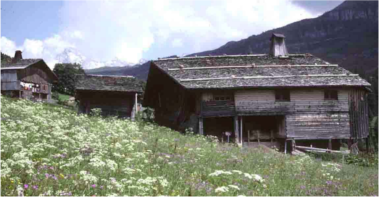
Chenailon (Haute-Savoie), 1987. chalet accompagné de son « trésor », un petit bâtiment servant à garder les denrées précieuses, les papiers de famille ...
