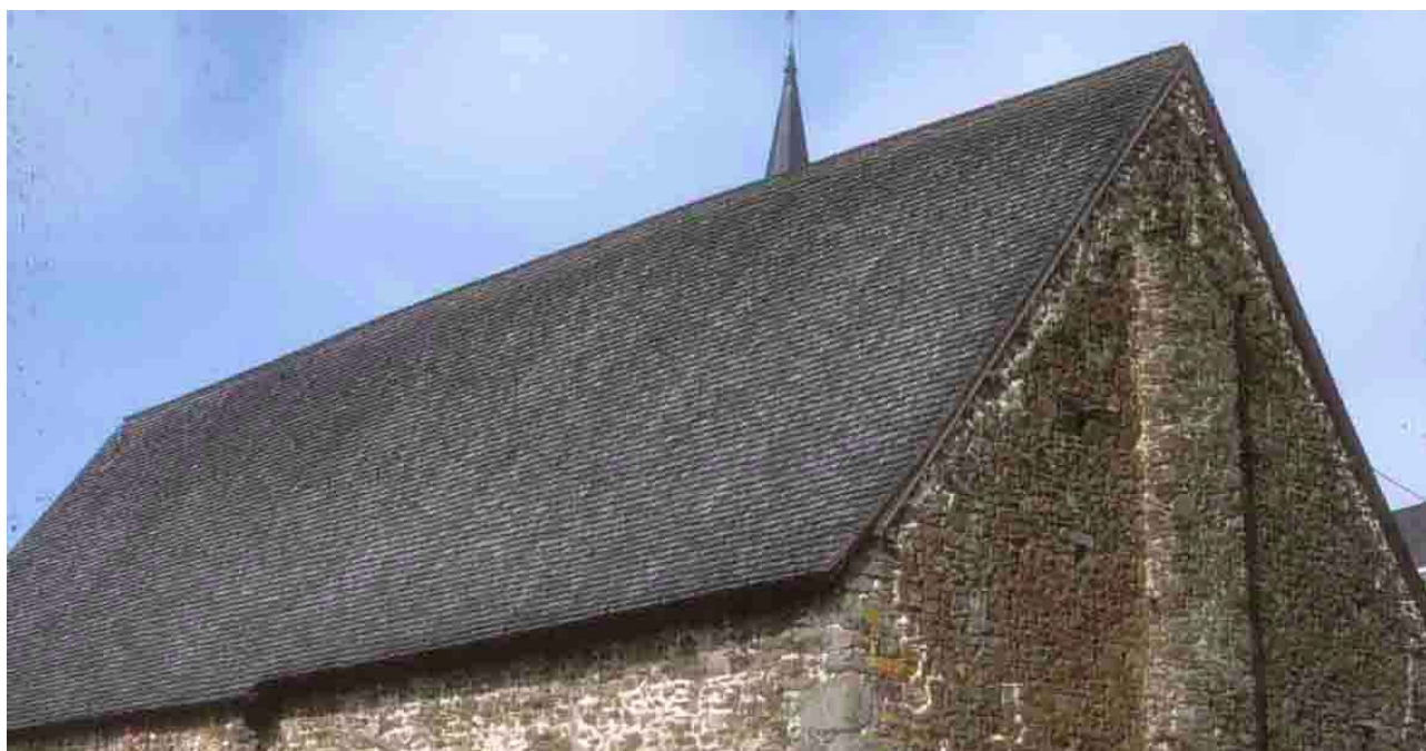
Montenay (Mayenne), 1994, grange restaurée en bardeaux de châtaignier.
