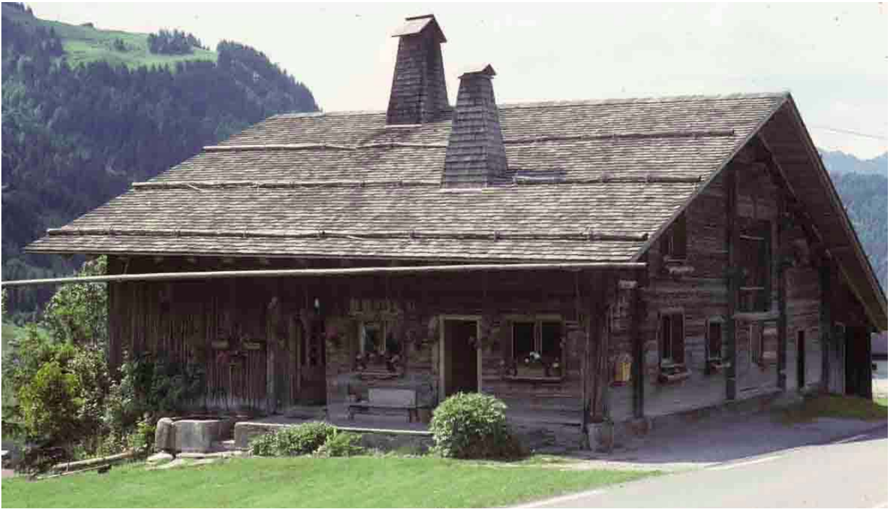
La Clusaz (Haute-Savoie), 2001, toit récemment restaurée. La petite cheminée, à l'avant droite, camoufle un tuyau d'aération disgracieux.
