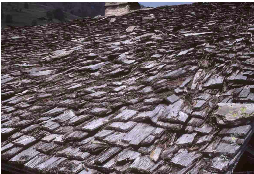
Saint-Sauveur, une couverture passablement désordonnée.
