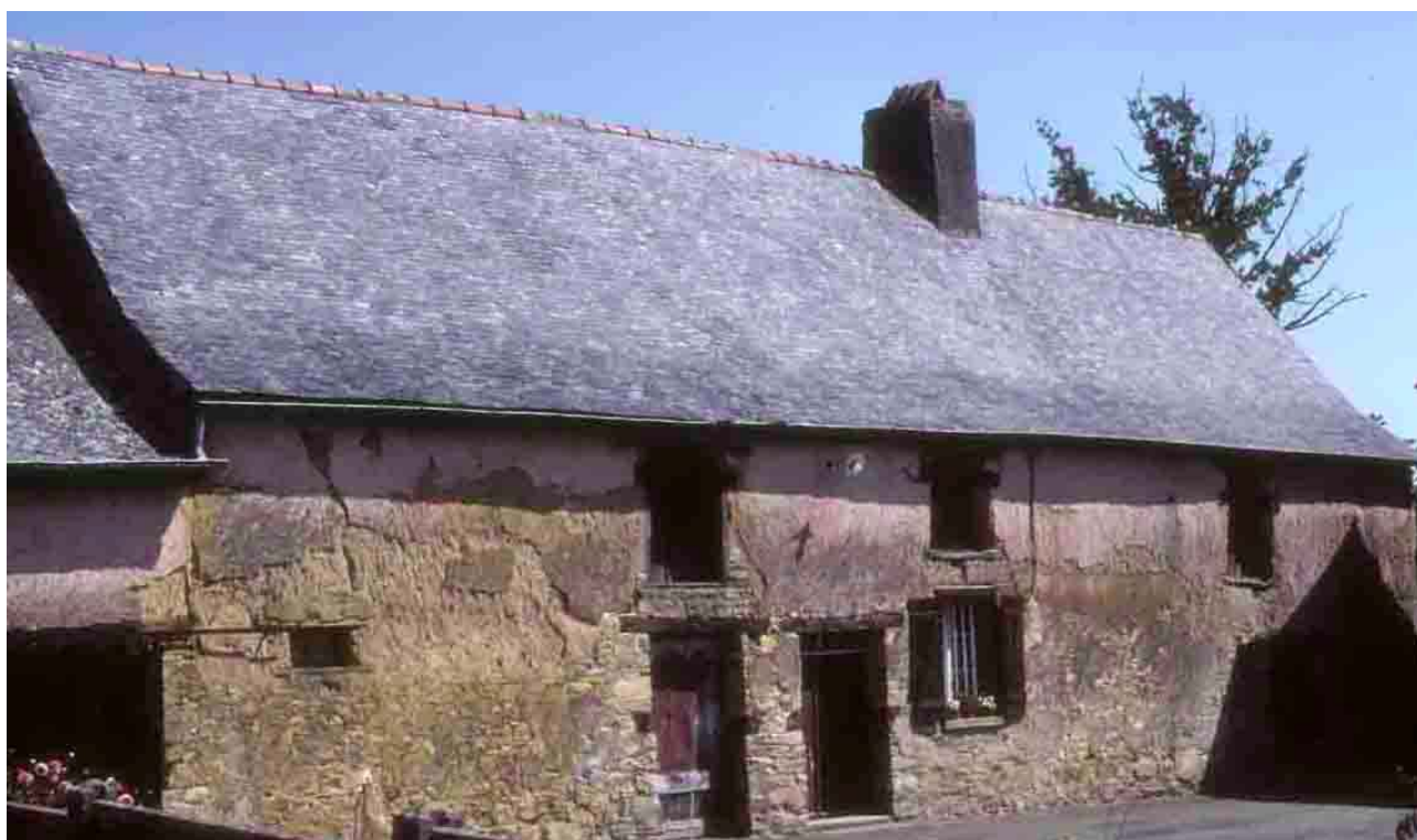
Saint-Aubin l'Aubépine (Ille-et-Vilaine), 2005. Maison en terre du bassin de Rennes.
