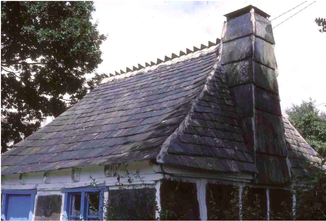
Landiscat la Loge Michel (Côte d'Armor), toiture de loge d'ardoisier, dont les maçonneries sont faites de larges plaques d'ardoise dressées.
