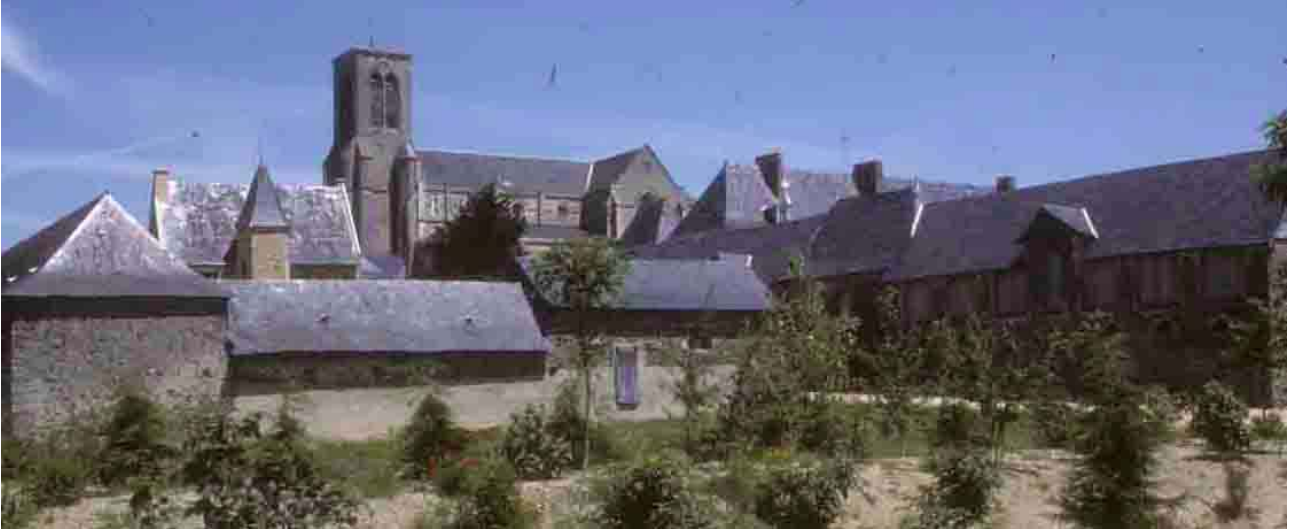
Craon (Mayenne), 1994, un matériau est d'autant plus mis en valeur qu'il engendre une harmonie d'ensemble.
