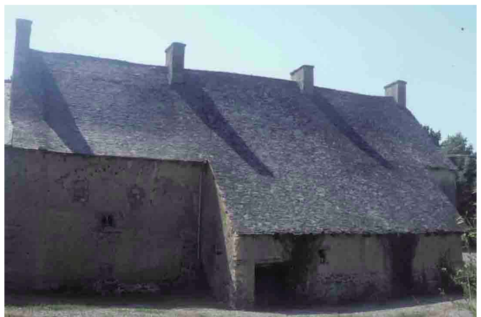
La façade arrière, prolongée très bas par un appentis. Le nombre de cheminées témoigne du confort domestique de cette maison.
