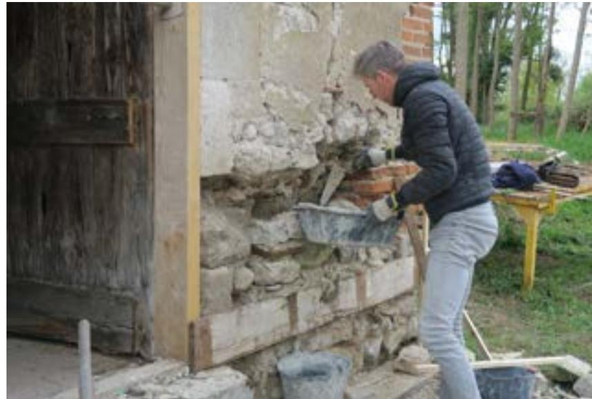
L'ajustage de la porte se poursuit avec Michel par l'ajout d'une baguette latérale. Une traverse en chêne sera posée en bas comme jet d'eau
