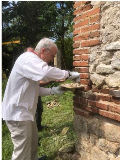
Les briques défectueuses sont complètement remplacées en tiroir. Lorsqu'il est pas possible de les extraire complètement, une demi-brique est posée en parement.
